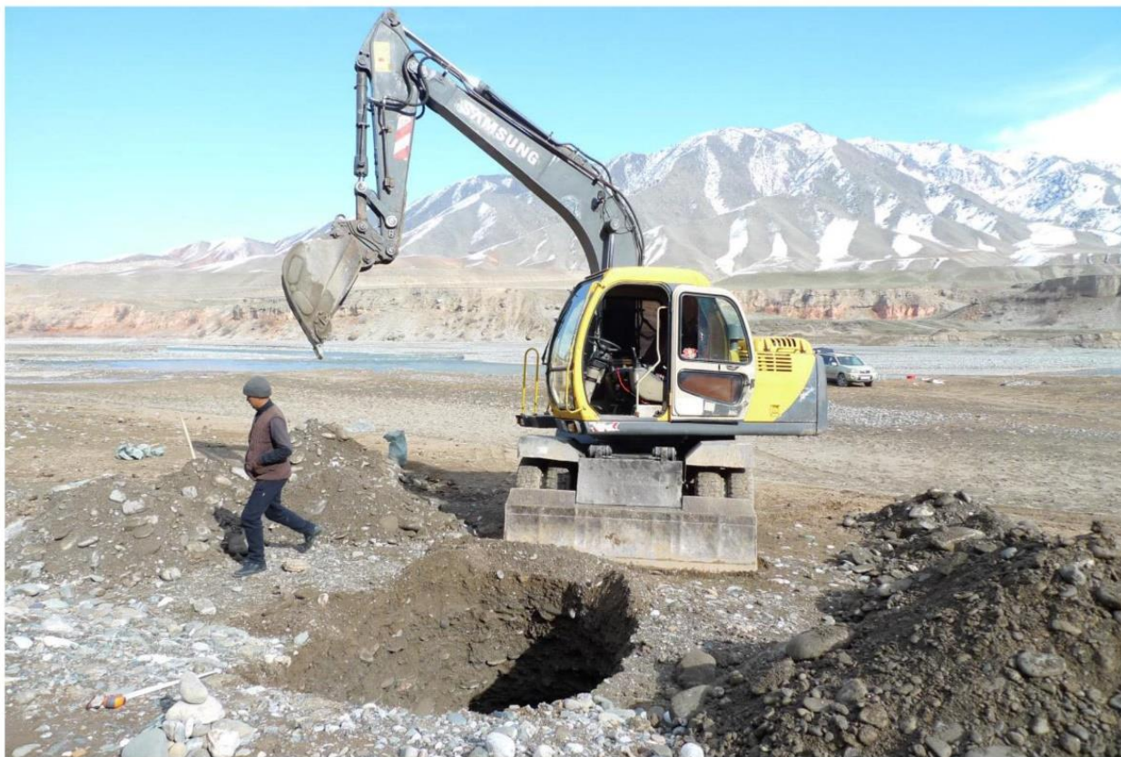
Фото 1. Механизированная проходка шурфов
